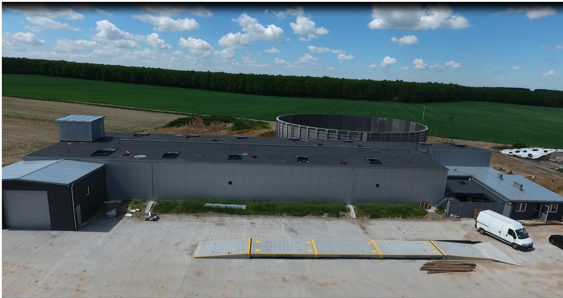
Druga biogazownia w technologii Pro Bio Gas powstająca w Chotyczach
