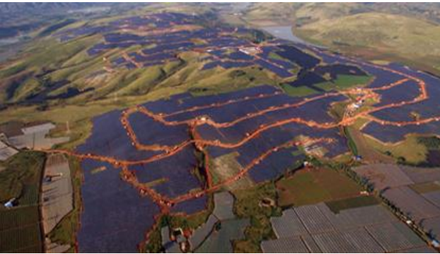
300 MW Yunnan, Chiny 1 132 080 modułów Trina Solar
