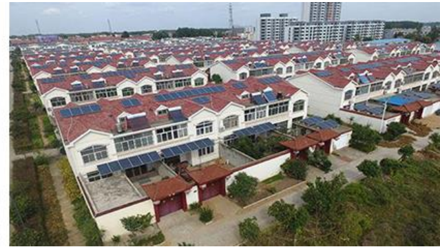
381kW Jiangsu, Chiny 129 budynków podłączonych do sieci
